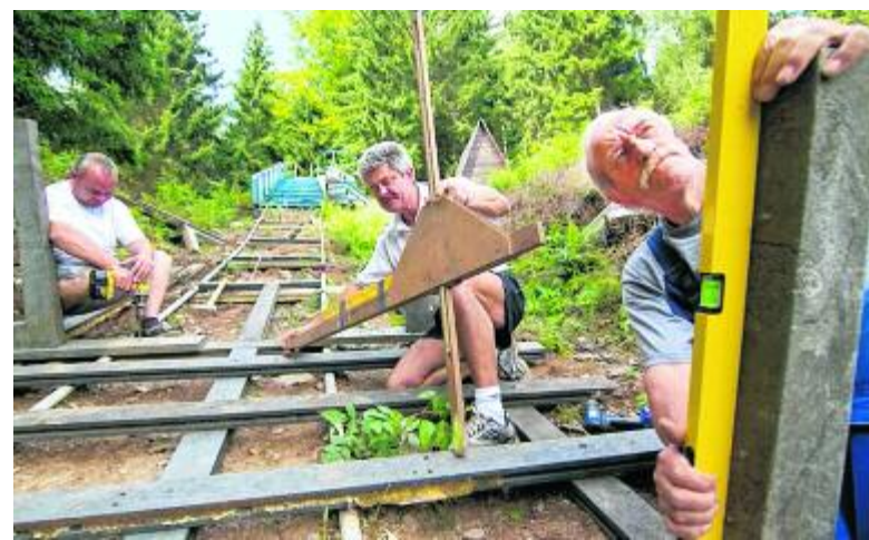
Bei dem Projekt des Skisportvereins Geyer soll vor allem die Anlaufspur der Schüler-Schanze erneuert werden. Derzeit wird der Untergrund vorbereitet. Im Bild: René Pruske, Joachim Starke und Bernd Gottschall (v. l.). FOTO: B. MÄRZ
